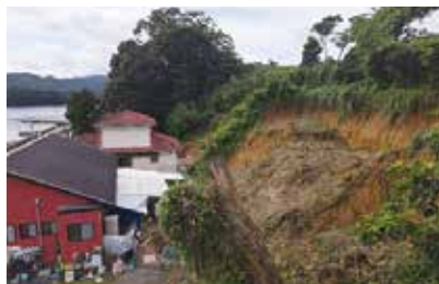
人家裏の斜面崩壊(令和3年 西海市)
