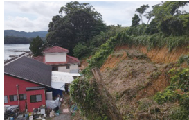
人家裏の斜面崩壊 (令和3年 西海市)
