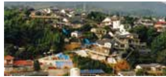
人家裏の斜面が崩壊(平成18年 五島市)
