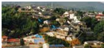
人家裏の斜面が崩壊(平成18年 五島市)
